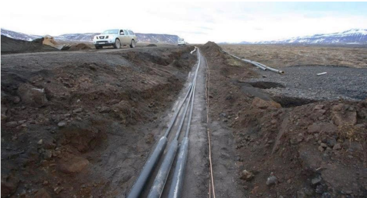
Mynd 3.6 Dæmi um strenglagningu á 66 kV streng meðfram uppbyggðum vegi.
