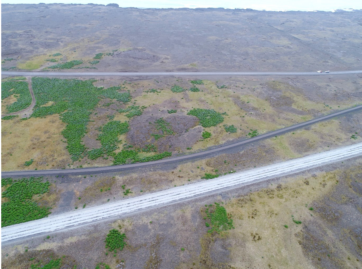
Mynd 4.7 Horft í suður yfir Suðurstrandarveg, hjólastíg og Laxabraut. Strengirnir verða í suðurkanti hjólastígsins.
